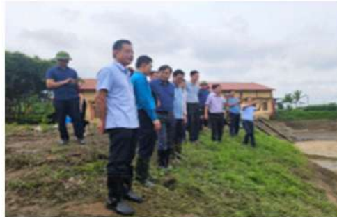
Thứ trưởng Nguyễn Hoàng Hiệp cùng đoàn công tác kiểm tra sự cố mạch đùn, mạch sủi tại trạm bơm Cẩm Bào và sạt lở bờ, bãi sông đoạn K8+100-K8+500, đề tả Cầu – Bắc Ninh
